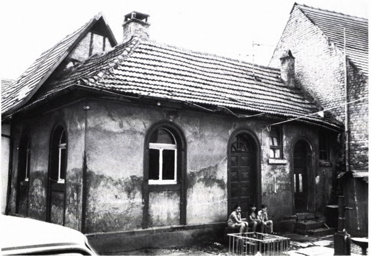
7 BADHAUS, an der Südseite des jüdischen Gemeindezentrums von Hemsbach gelegen. Ansicht von Nordosten.
