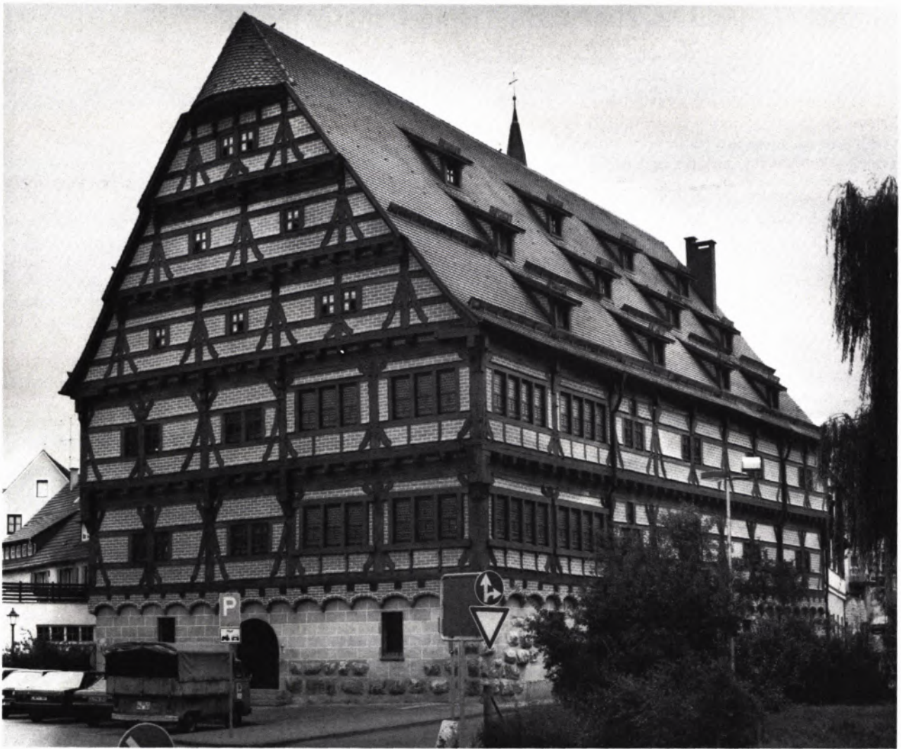
5 EHINGEN, DAS NEUHAUS von Westen nach der Instandsetzung. Die Lage der Stuben wird durch die Fensterbänder gekennzeichnet. Die Bohlenwände sind außen wegen einer Ziegelvormauerung nicht sichtbar.
