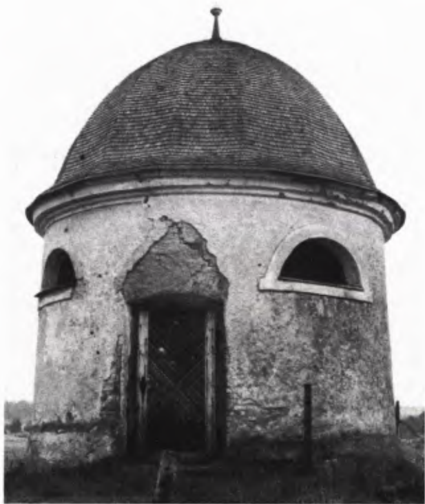
5 DAS BRUNNENHAUS in Obermarchtal, errichtet um 1720 (Zustand 1971).
