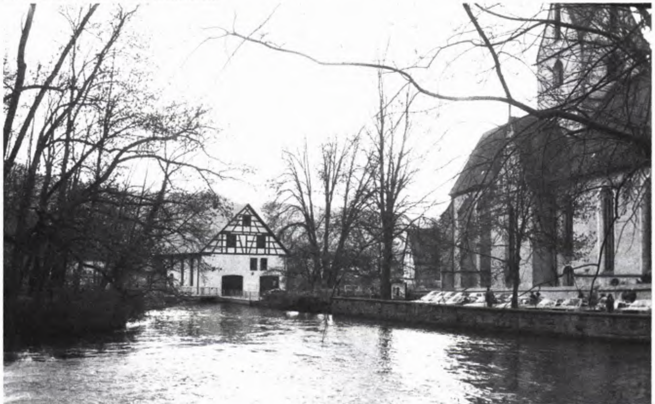
12 DAS PUMPWERK IN BLAUBEUREN, das 1875 nach Plänen von Karl Ehmann errichtet wurde. Im Vordergrund der Blautopf mit der Blau, rechts die ehem. Klosterkirche.
