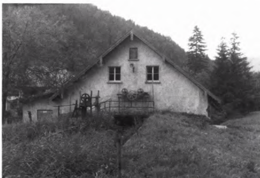
11 DAS PUMPWERK mit dem heute zugewachsenen Kanal im Vordergrund.
