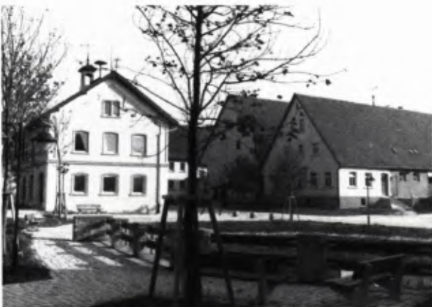
14 „SANIERTE“ HÜLE in Seißen.
