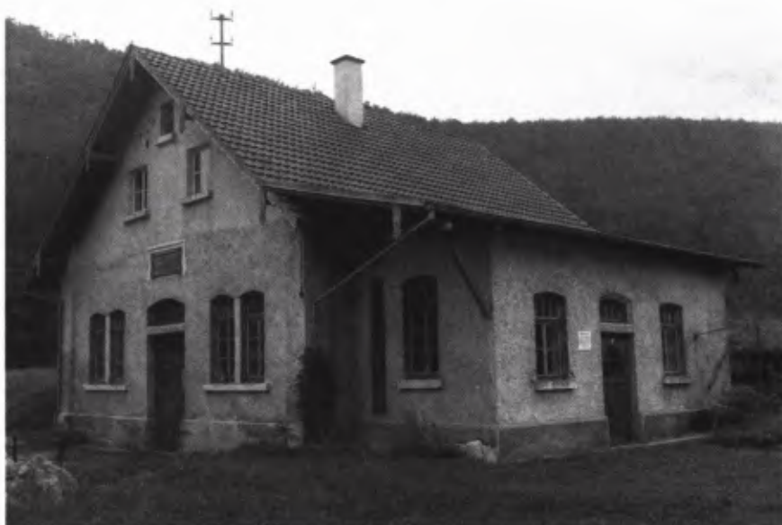
10 DAS PUMPWERK in Schelklingen-Teuringshofen. Errichtet als erstes Pumpwerk der Albwasserversorgung nach Plänen von Karl Ehmann 1870.
