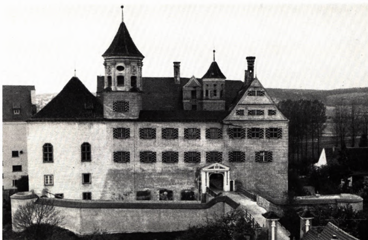
SCHLOSS BRENZ VON OSTEN. Der burghaft geschlossene, auf einer ins Brenztal vorstoßenden Felsenzunge stehende Komplex wird gegen Osten, die Angriffsseite hin von einem mächtigen, von der seit 1672 ersetzten Güssenburg übernommenen Doppelgraben geschützt. Links der Flügel mit dem berühmten Rittersaal, rechts der Wohnflügel mit reizvoll ausgestatteten Zimmern. Die Wand zwischen diesen beiden Flügelbauten dürfte den Ort der alten Schildmauer einnehmen und geht mit ihren Fenstern auf die offenen Umgänge der Hofgalerien.
