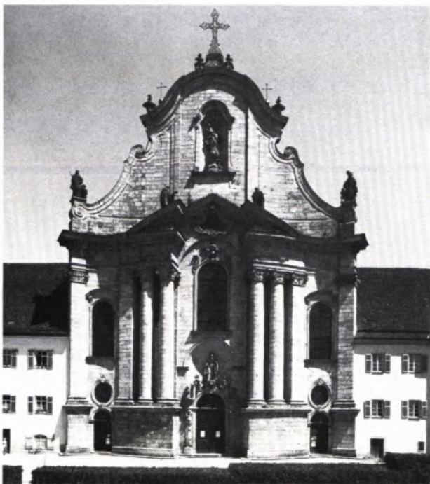
WESTFASSADE DER ZWIEFALTENER KLOSTERKIRCHE mit den anschließenden ehemaligen Klostergebäuden, hier in einer Aufnahme von 1963. Durch Untersuchungen ließ sich nur noch der Farbton der Grundfläche belegen. Es gab an der Fassade keine Hinweise mehr auf die ursprünglichen Putzstrukturen und die Behandlung der Architekturgliederungen.
