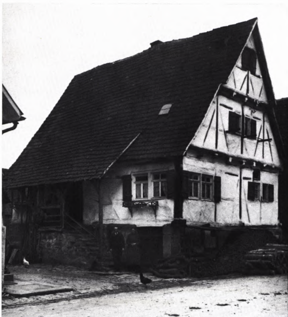
3 ECHTERDINGEN. Bauernhaus, Zustand um 1910. Das Sichtfachwerk ist unter der Kalktünche zum Teil wieder freigewittert.
