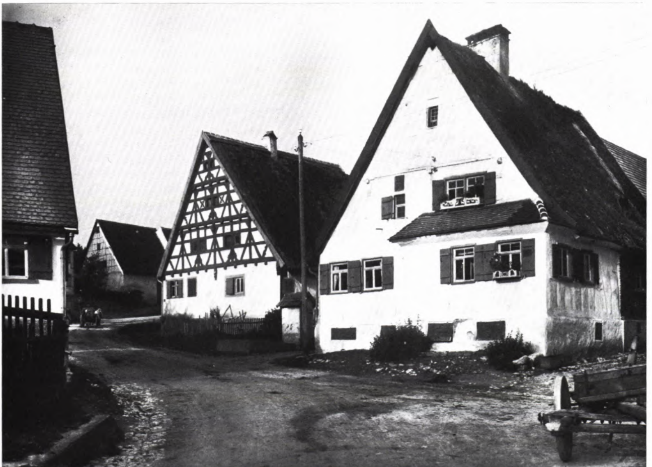
5 LAICHINGEN, Alb-Donau-Kreis, um 1910. Die beiden strohgedeckten Bauernhäuser wurden etwa zur gleichen Zeit (um 1600) errichtet. Das linke dürfte frisch als Sichtfachwerk wieder herausgeputzt worden sein, das rechte zeigt noch den Zustand um 1800.
