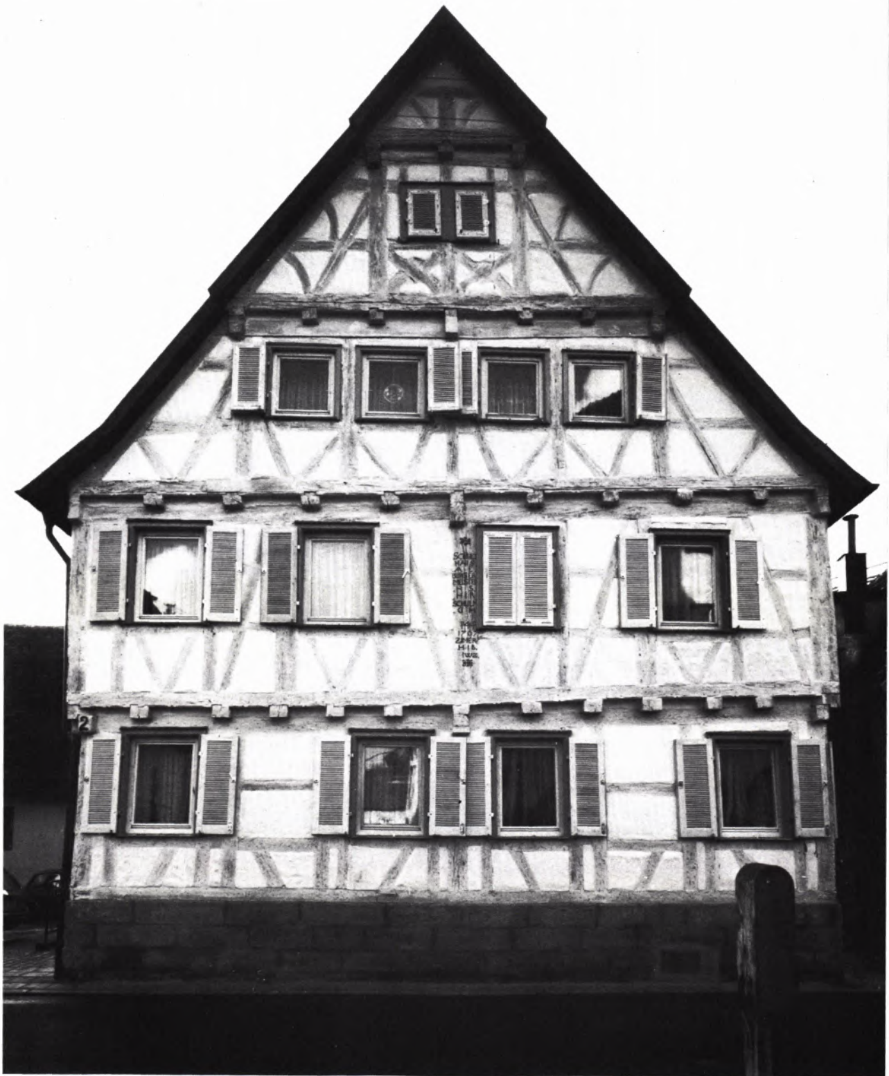
1 STUTTGART-VAIHINGEN. Nach der Restaurierung. Der Wiederanstrich des Holzes wird stärker deckend sein.
