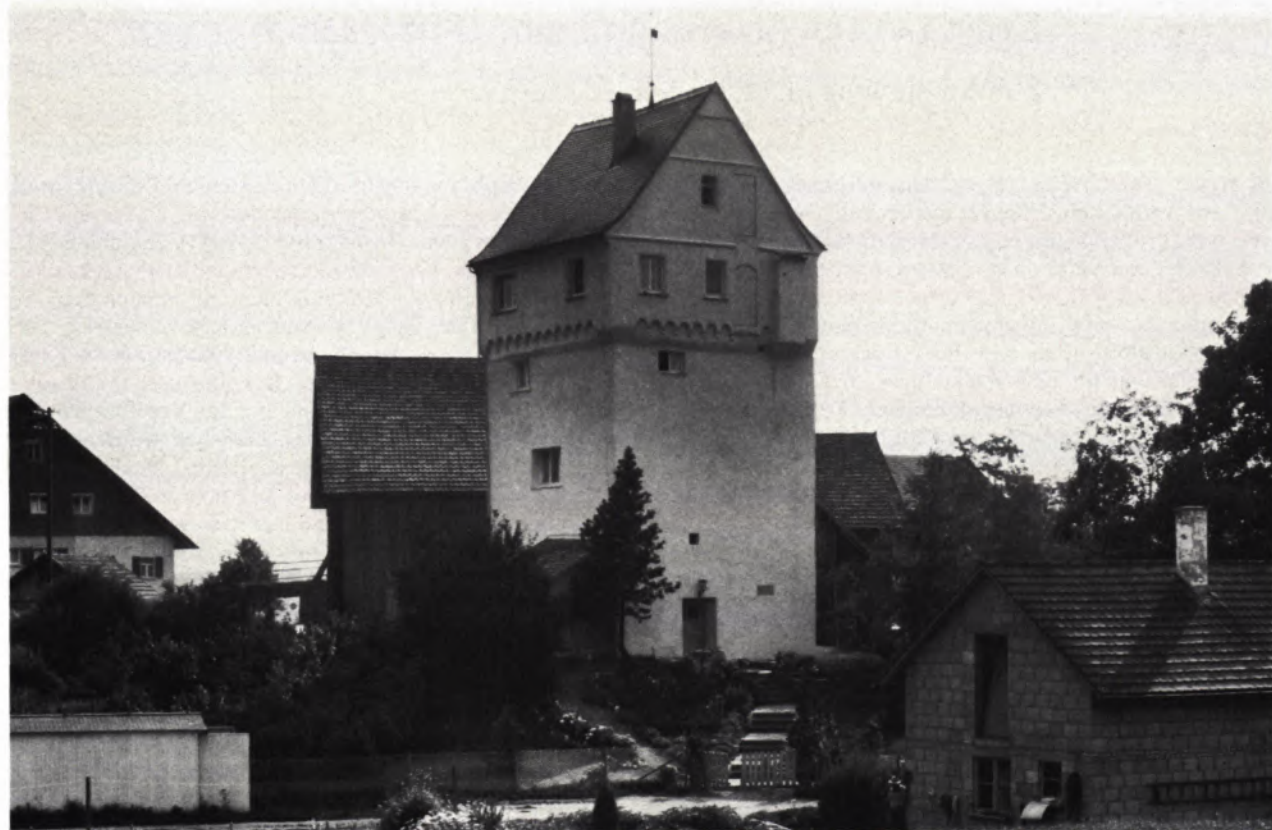
3 ERHALTENE TURMHÜGELBURG VON DEUCHELRIED-OFLINGS, Kreis Wangen. Sie veranschaulicht das Erscheinungsbild der ältesten Bauphase der Burg Liebenau.
