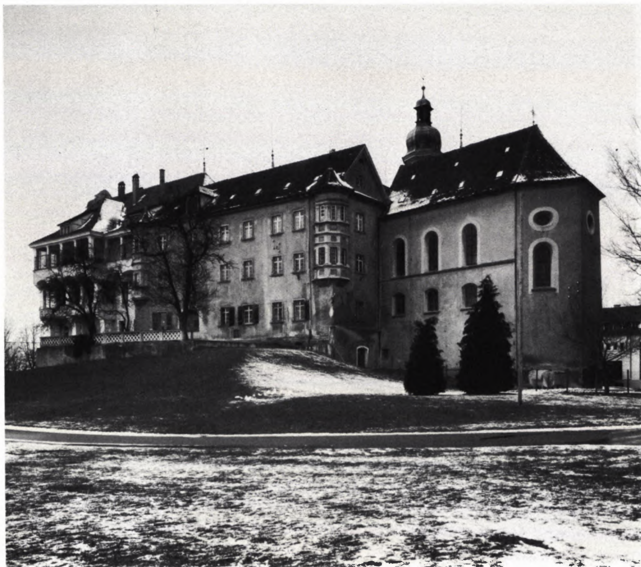
1 EHEMALIGES SCHLOSS LIEBENAU in Meckenbeuren. Ansicht von Süden vor Beginn der Umbauarbeiten. Die Reliefformen lassen deutlich erkennen, daß Teile des Baues auf einem mittelalterlichen Burghügel stehen.
