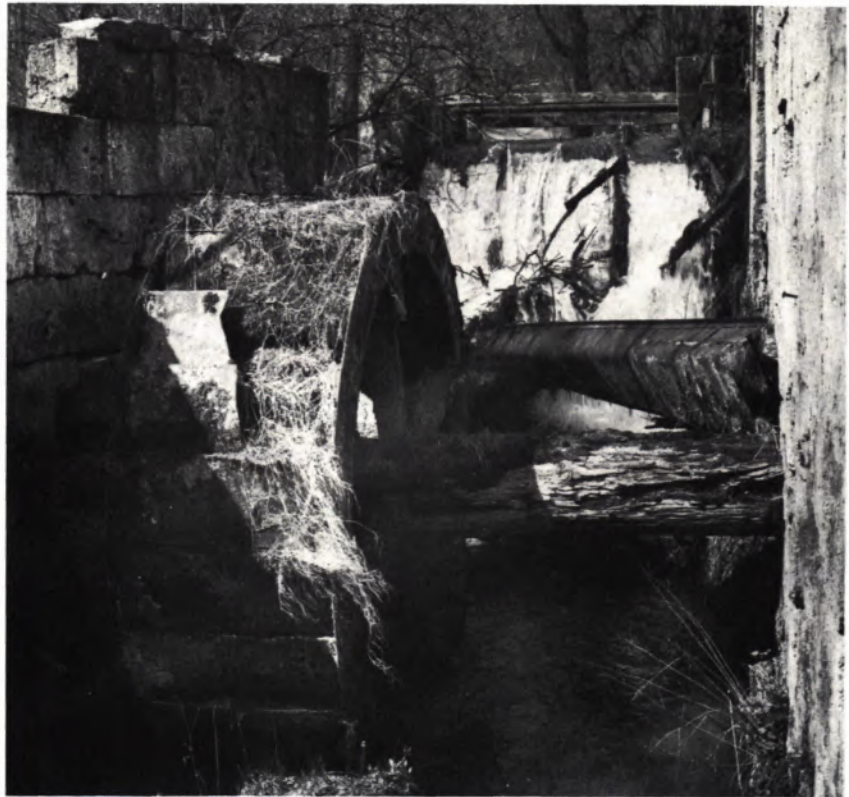
◁ 1 und 2 RIEDMÜHLE in Sondernach, Alb-Donau-Kreis. Einzige Mühle im Regierungsbezirk, die noch Reste von mehreren – hier vier – hintereinander angeordneten kleineren Mühlrädern und damit das vor der Industrialisierung des 19. Jahrhunderts gültige Prinzip zeigt. Auf dem Grundriß sind links die vier versetzt angeordneten Mühlräder zu sehen.
