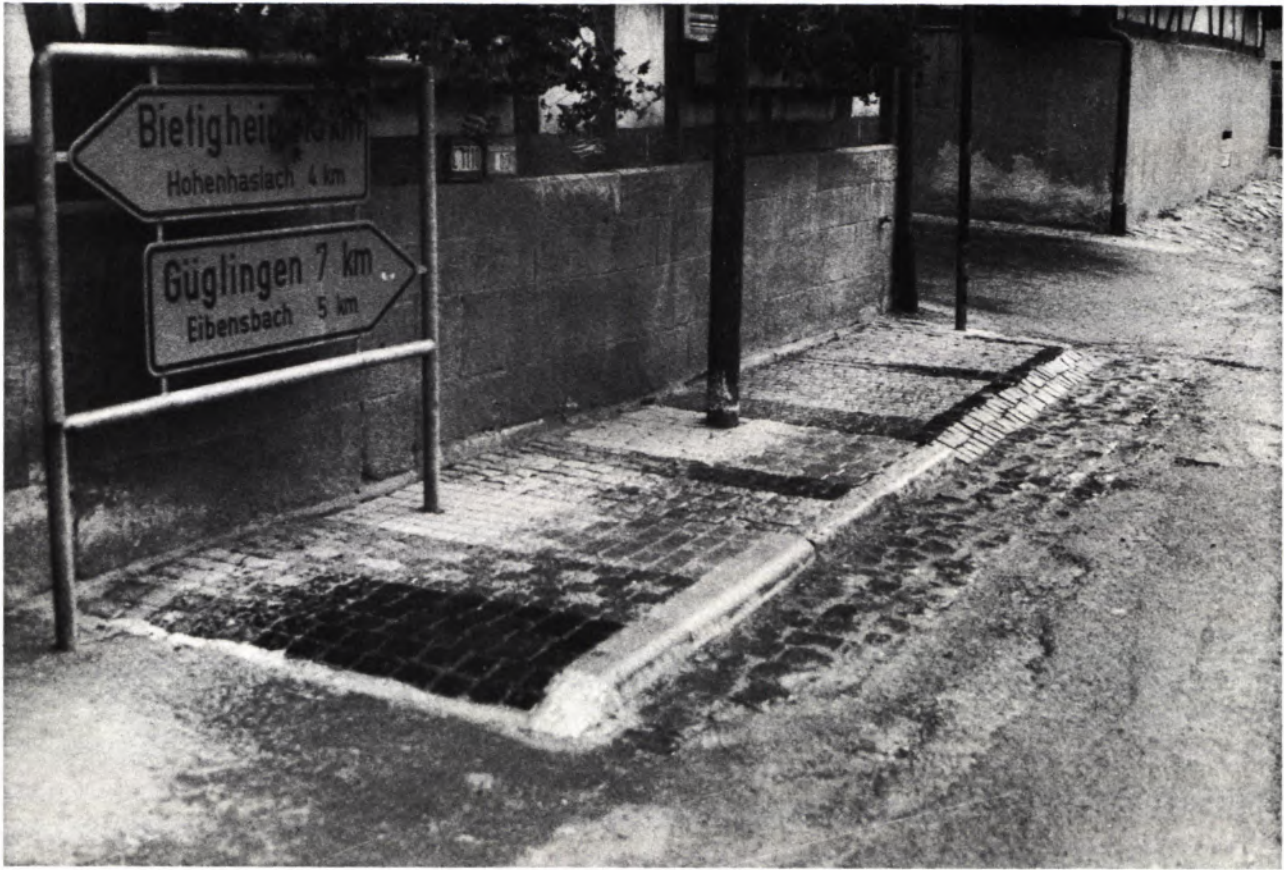
3 OCHSENBACH, Proben unterschiedlicher Gehwegbeläge und Randeinfassungen vor dem Rathaus.
