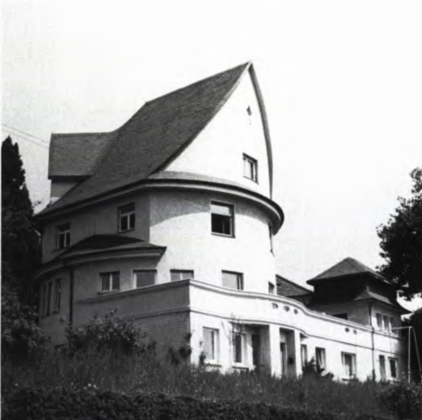
5 RAVENSBURG, VILLA STADTBlick 2, erbaut 1913 von dem Architekten Gustav Eichler für sich und seine Frau; ein Musterbeispiel für eine eigenwillige, dennoch in der Zeit stehende Lösung einer Bauaufgabe.
