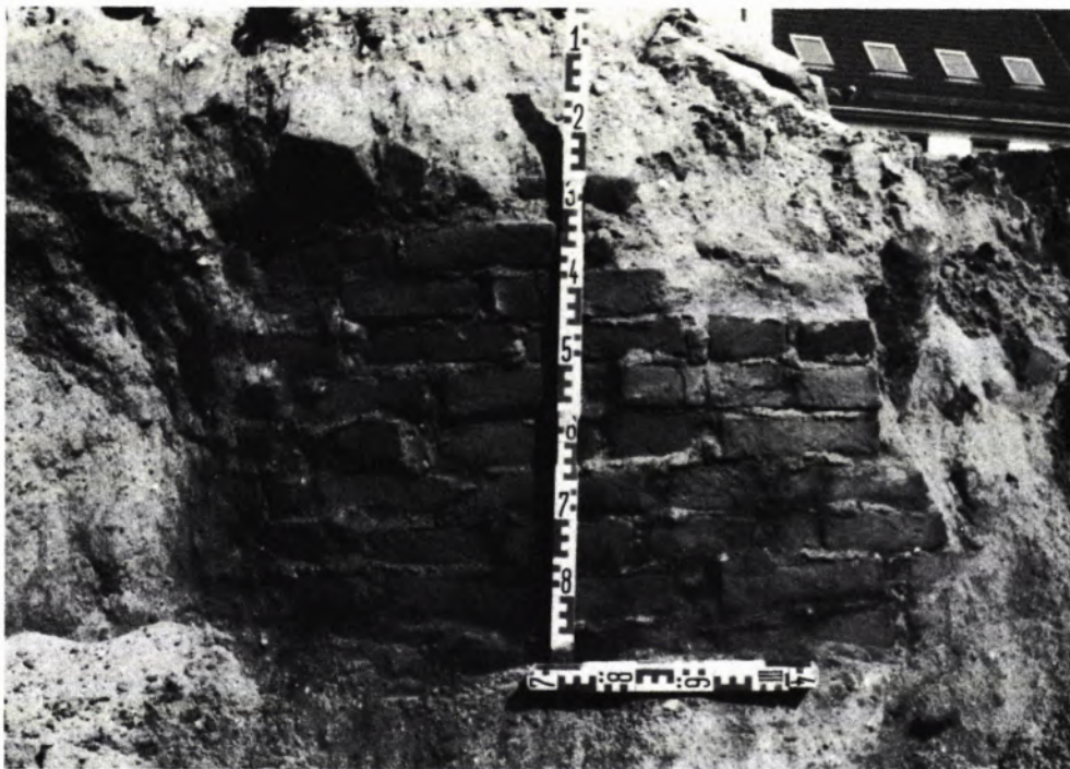
3 GEMÖRTELTEN BACKSTEINMANTEL am unteren Schachtende, von außen gesehen.
