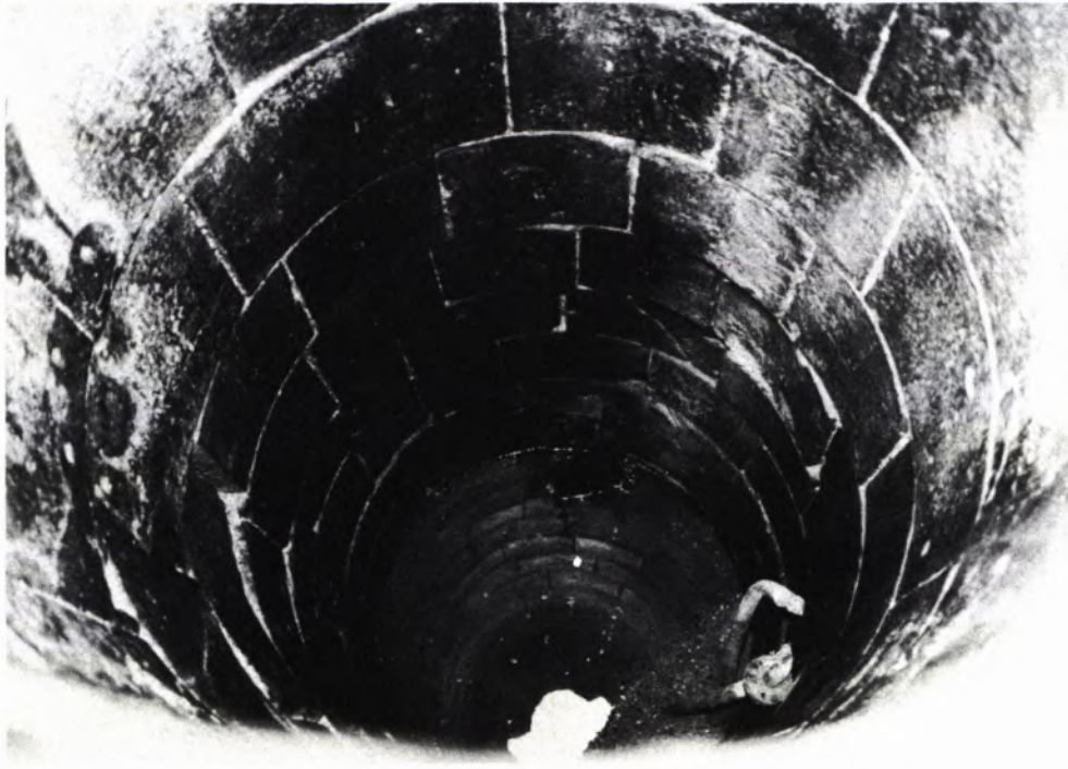
2 BLICK IN DEN BRUNNENSCHACHT, der aus ungemörtelten Sandsteinplatten aufgeführt war.
