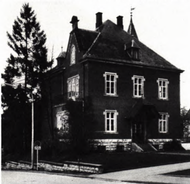
19 SIGMARINGEN. Direktorhaus des ehemaligen Gymnasiums.
