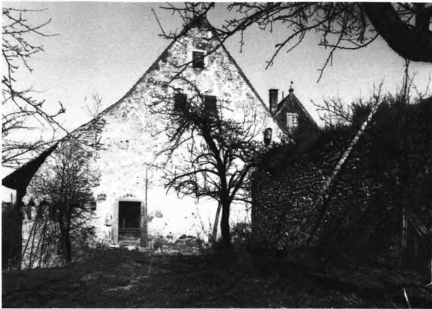
16 ROTTENBURG. „Alte Welt“. Scheune.
