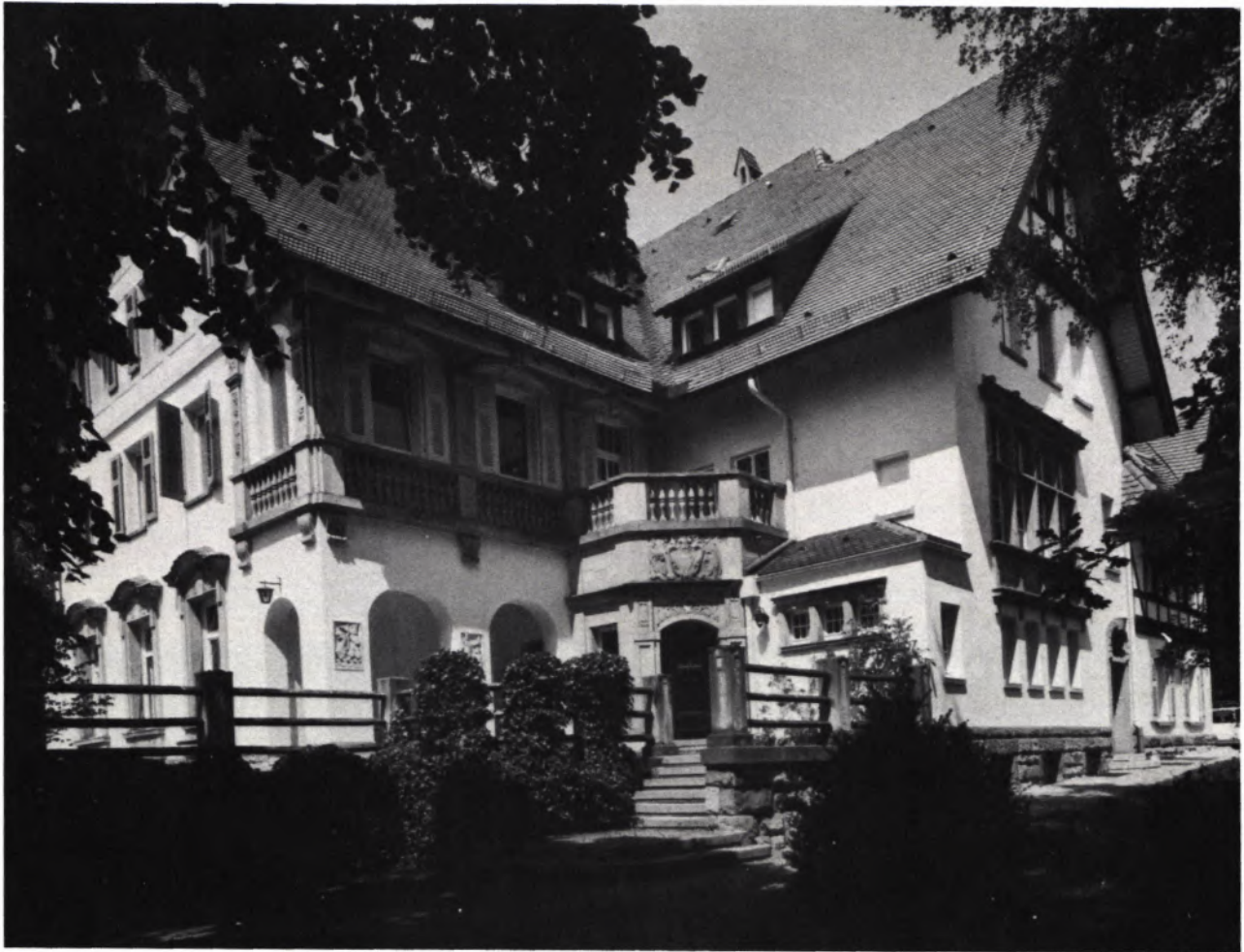
1 TÜBINGEN. STAUFFENBERGSTRASSE 21. Haus der Studentenverbindung Normannia. Eingangsseite im Südwesten.
