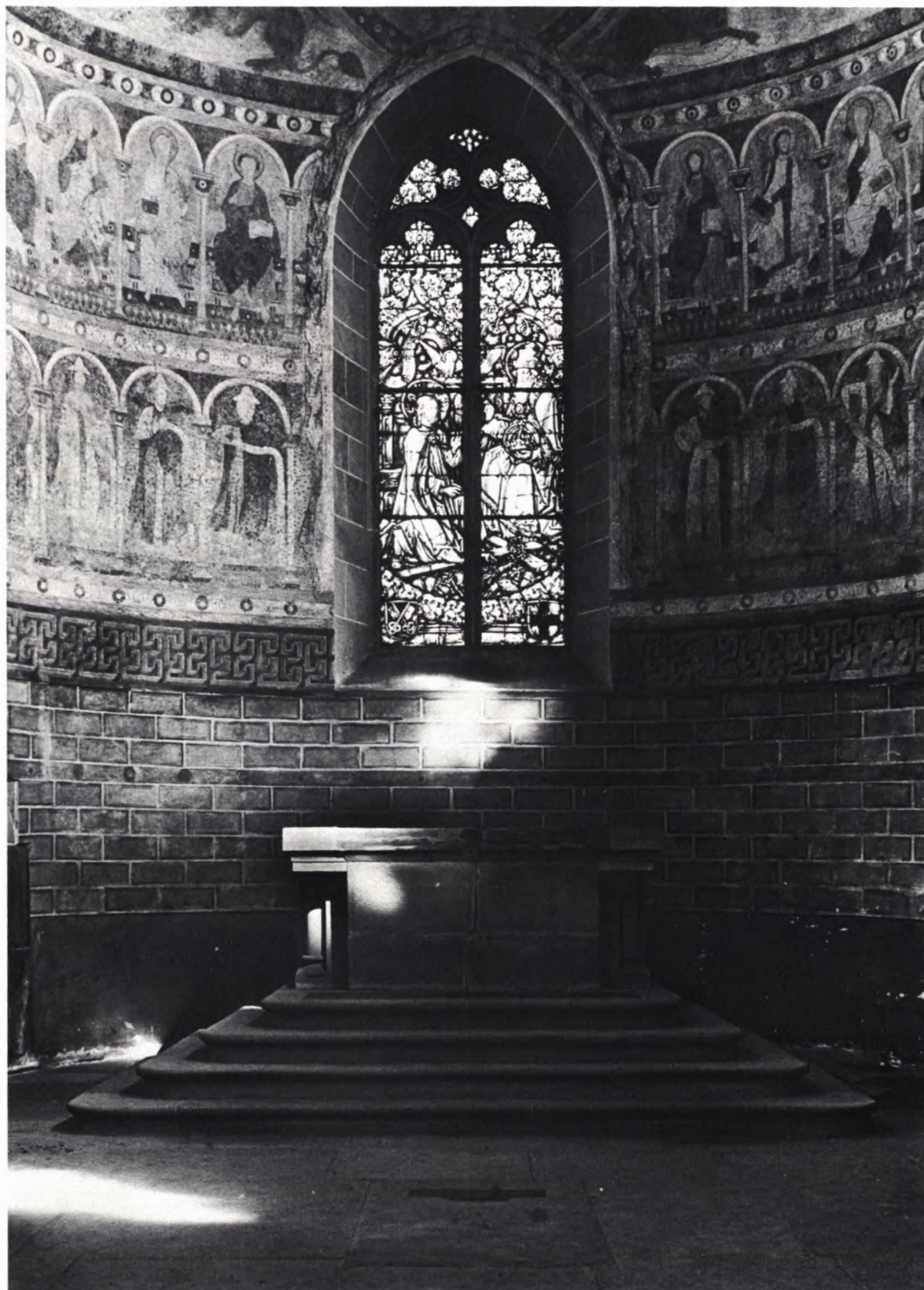
1 REICHENAU-NIEDERZELL. STIFTSKIRCHE ST. PETER UND PAUL. Apsisaltar zu Beginn der Restaurierungsarbeiten mit Stufenbau und neuromanischer Verbreiterung um 1900.
