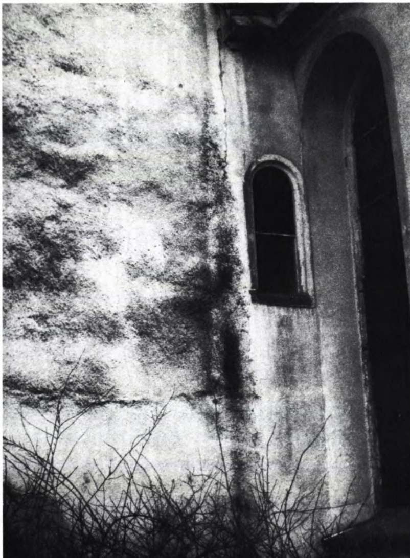
6 MAUERFUGE ZWISCHEN TURM UND KIRCHE von St. Mariin in Kirchdorf. Ansicht von Osten.
