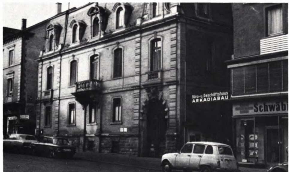
12 ZUSTAND DES GEBÄUDES Myliusstraße 8 vor dem kürzlich erfolgten völligen Umbau.
