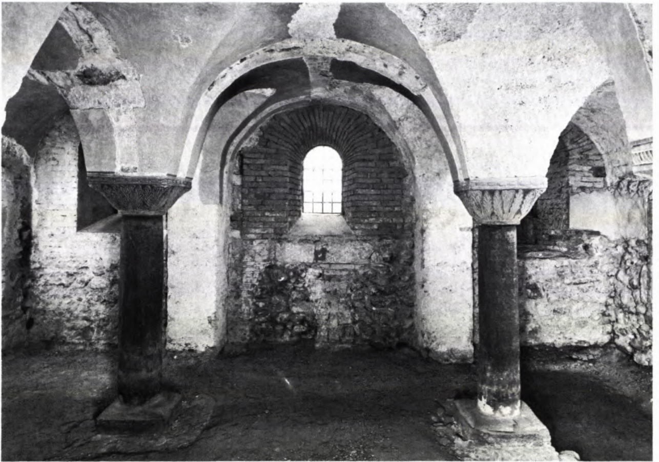
4 MÜNSTER UNSERER LIEBEN FRAU IN KONSTANZ. Blick in die Krypta nach Osten, aufgenommen nach Abschluß der Sondierungsarbeiten.
