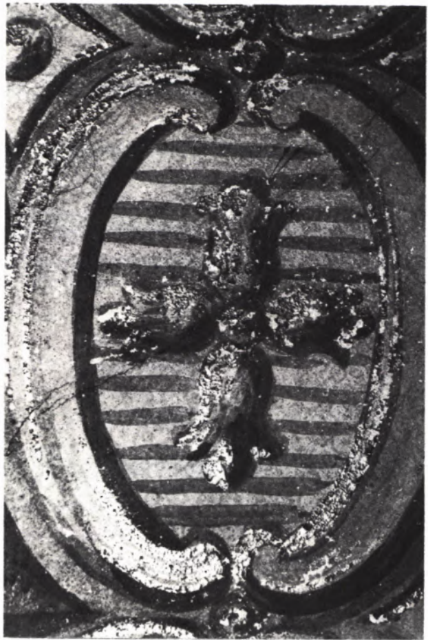
9 Versprödete Mordentvergoldung in den Brokaten des Psallierchores mit aufstehenden Rändern.
