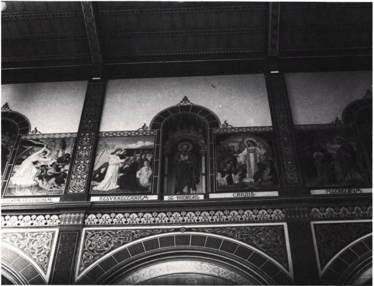
2 ARKADENBÖGEN UND OBERGADEN des Mittelschiffes mit Nischen anstelle ursprünglich geplanter Fenster, nach der Restaurierung der Bemalung.
