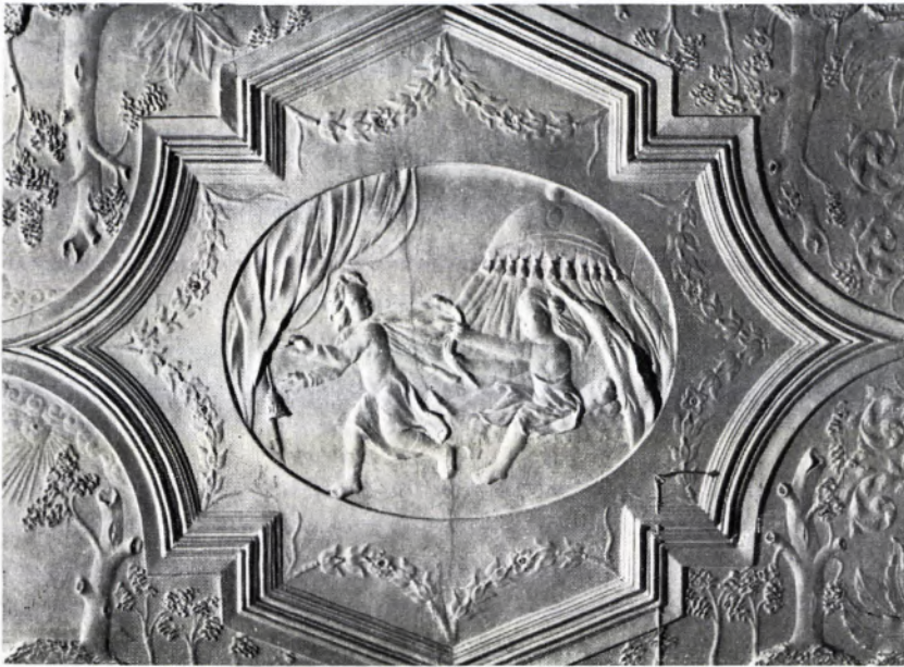
2 DIE STUCKDECKEN des ersten Obergeschosses, entstanden im frühen 18. Jahrhundert, gehören zu den künstlerisch wichtigen Bauteilen des „Schlößle“.
