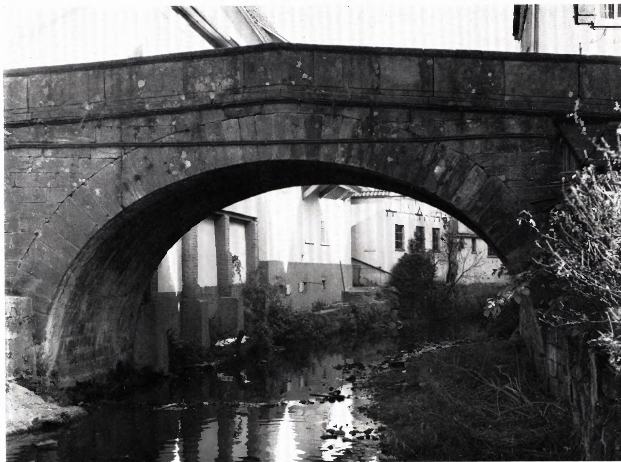
BLICK VON SÜDWESTEN AUF DAS HAUPTJOCH DER ALPIRSBACHER KINZIGBRÜCKE. Auch ohne viele Worte wird die Eleganz spürbar, mit welcher sich das Brückenbauwerk über den Lauf der Kinzig schwingt. Die saubere, handwerklich einwandfreie Steinmetzarbeit, die am Steingefüge wie an der Ausarbeitung der krönenden Brüstung erkennbar wird, will sich allerdings nur schlecht verbinden mit dem eher gedankenlos aufgenagelten modernen Kabelwerk.
