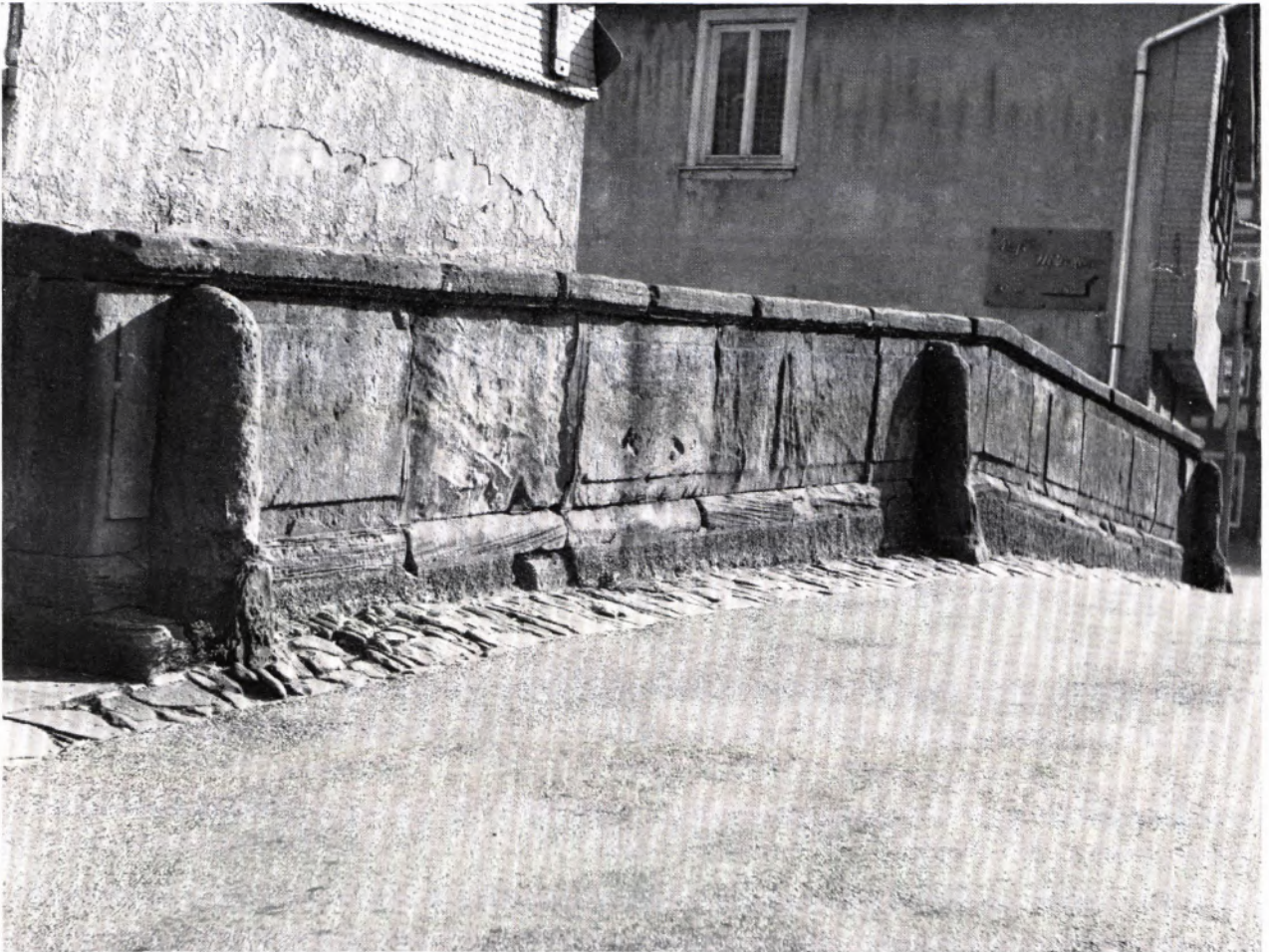
DIE NORDÖSTLICHE BRÜSTUNG DER ALPIRSBACHER KINZIGBRÜCKE. Die mächtigen Blöcke, aus denen die Brüstung gefügt ist, mußten mit Rücksicht auf den giebelförmigen Brüstungsablauf sehr sorgfältig in schwacher Trapezform zugerichtet werden. Dem Schutz der Brüstung dienen drei „Abweiser“, die das Anschlagen von Wagen verhindern sollten. Am Fuß der Brüstung ist noch ein Teil der (heute weitgehend überteerten) alten Pflasterung zu sehen.
