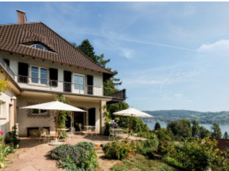
2 Das Museum Haus Dix von Westen nach der Instandsetzung 2013.
