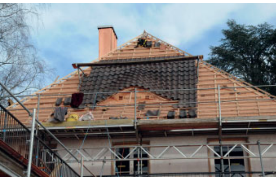
10 Wiederherstellung der Fledermausgauben, hier auf der Westseite.
