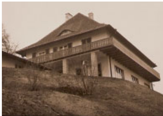
1 Historische Aufnahme des Hauses von Südwesten, ca. 1936/37.
