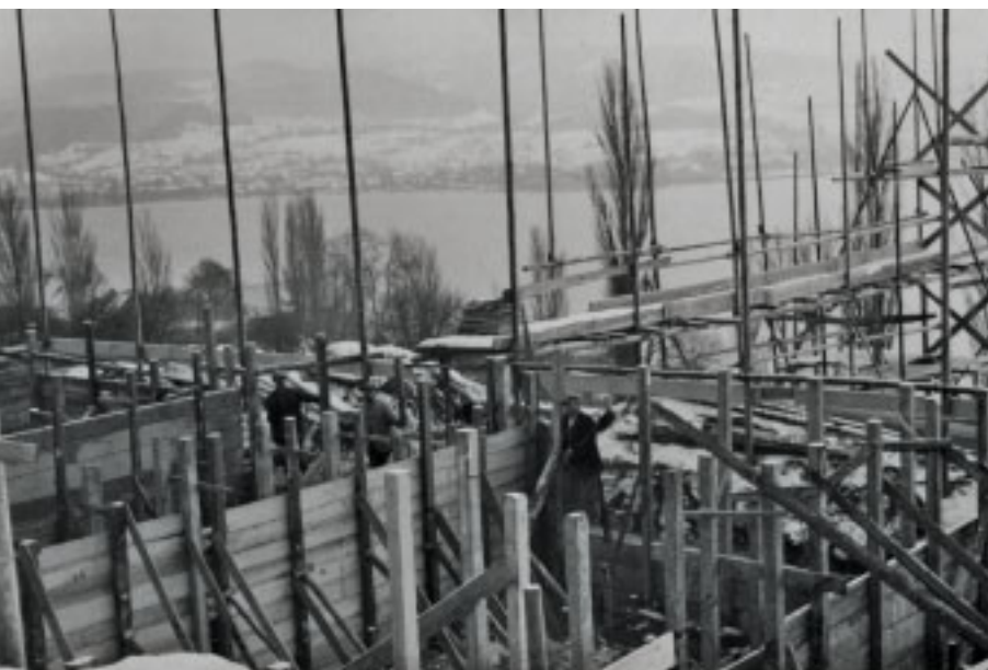
1 Die Baustelle im Winter 1935/36.
