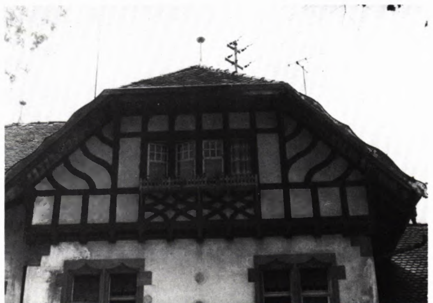
4 HAUPTGEBÄUDE LENZKIRCH. Mit verziertem Fachwerk wird dieser Teil der Bahnhofsgebäude gegenüber den Nebenbauten besonders betont.
