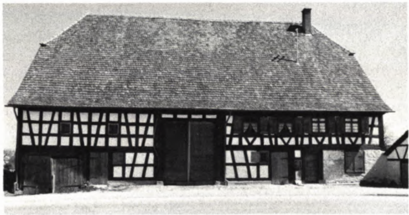
2 DAS GLEICHE HAUS nach seiner Fertigstellung 1980.
