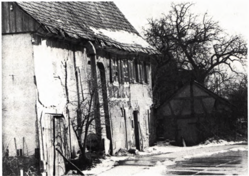
1 BAUERNHAUS in Rottweil-Hausen. Zustand 1979.
