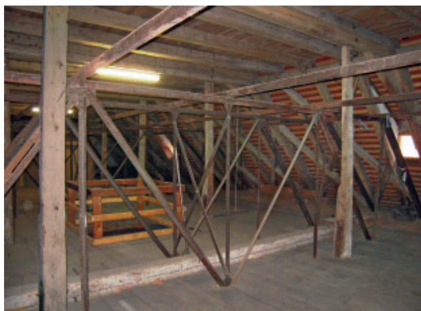
3 Dachraum über dem Kirchenschiff, Blick auf die Stahlkonstruktion des Scheingewölbes von 1929/30.
