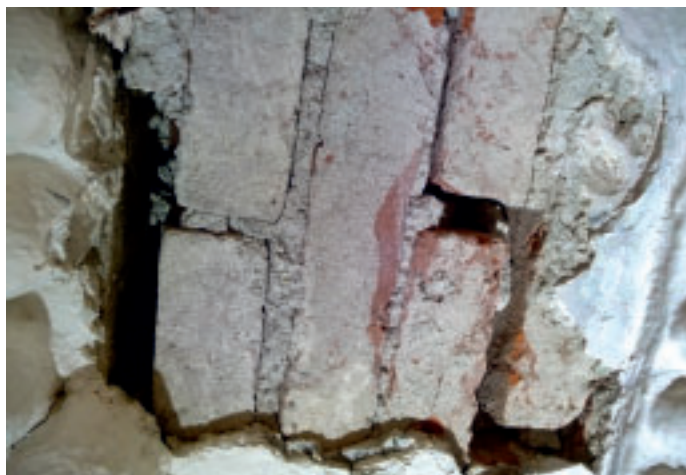
6 Chorgewölbe, Stuckergänzung nach der ersten Sicherungsmaßnahme 2008/09.
