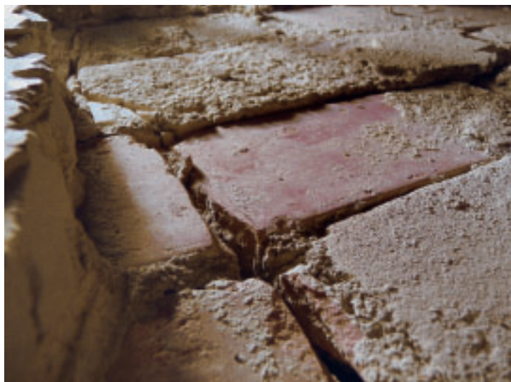
7 Chorgewölbe, Puttenkopf mit neu aufgetretenem Riss, Aufnahme Juni 2012.
