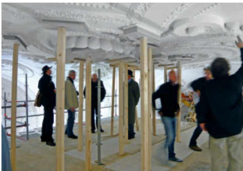
1 Gewölbeuntersicht mit Abstützungen während eines Ortstermins.
