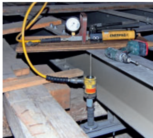
7 Federelement mit Anspannvorrichtung.
