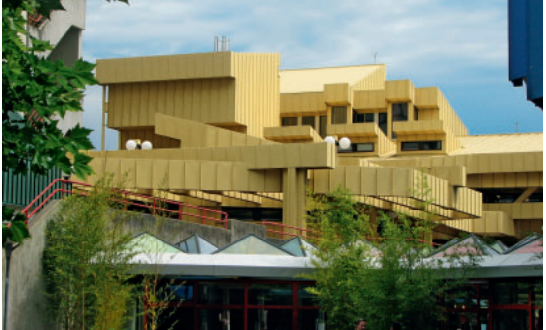
8 Mensa und Foyer – künstlerisch gestaltete Dachlandschaft im Zent- rum der Anlage, 2011.
