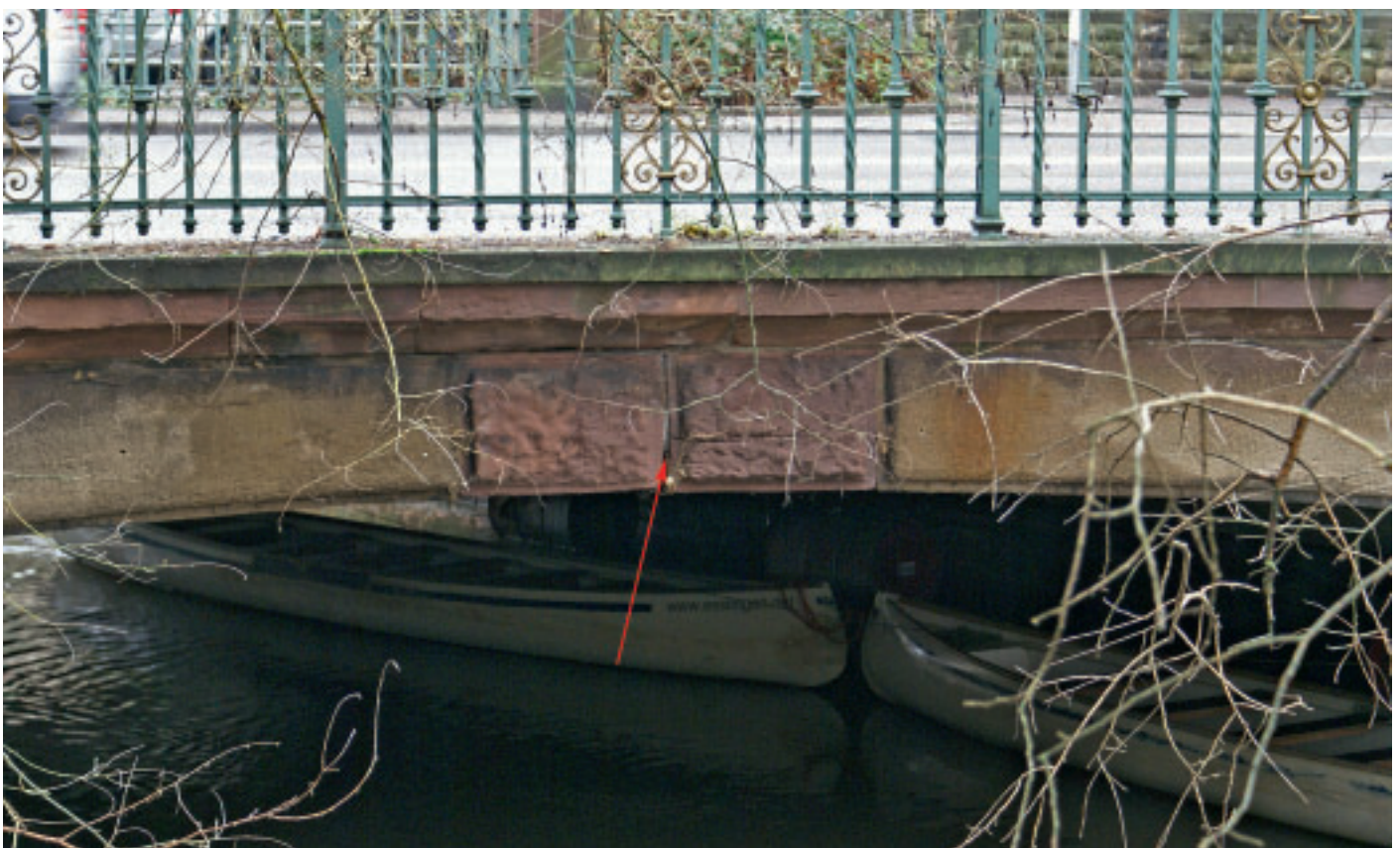
4 Scheitelgelenk der Hammerkanalbrücke.
