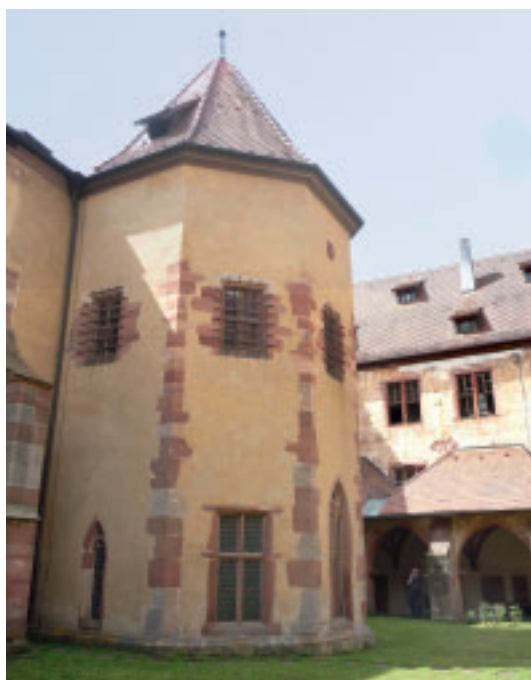
1 Brunnenhaus im Kreuzgang von Kloster Bronnbach, erbaut 1411 mit Aufstockung von 1520, Zustand 2014.
