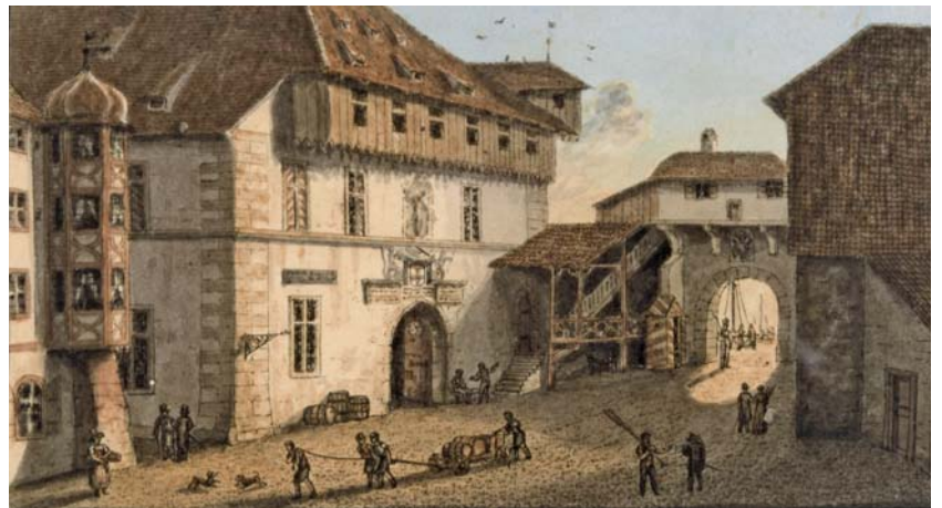
4 Fotografie des Kaufhauses von Südosten vor dem Bau der Eisenbahn 1863 und vor der Vergrößerung der Toröffnung, German Wolf 1861.
