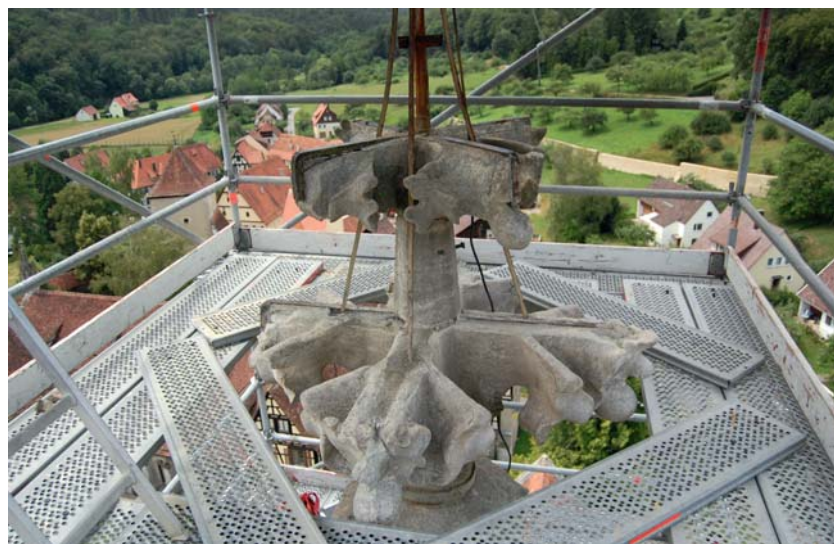
3 Blick auf die eingerüstete Turmspitze mit den beiden Krabbenkränzen.
