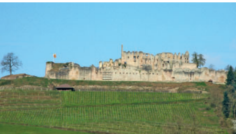
1 Die Ruine der Hochburg von Osten gesehen.
