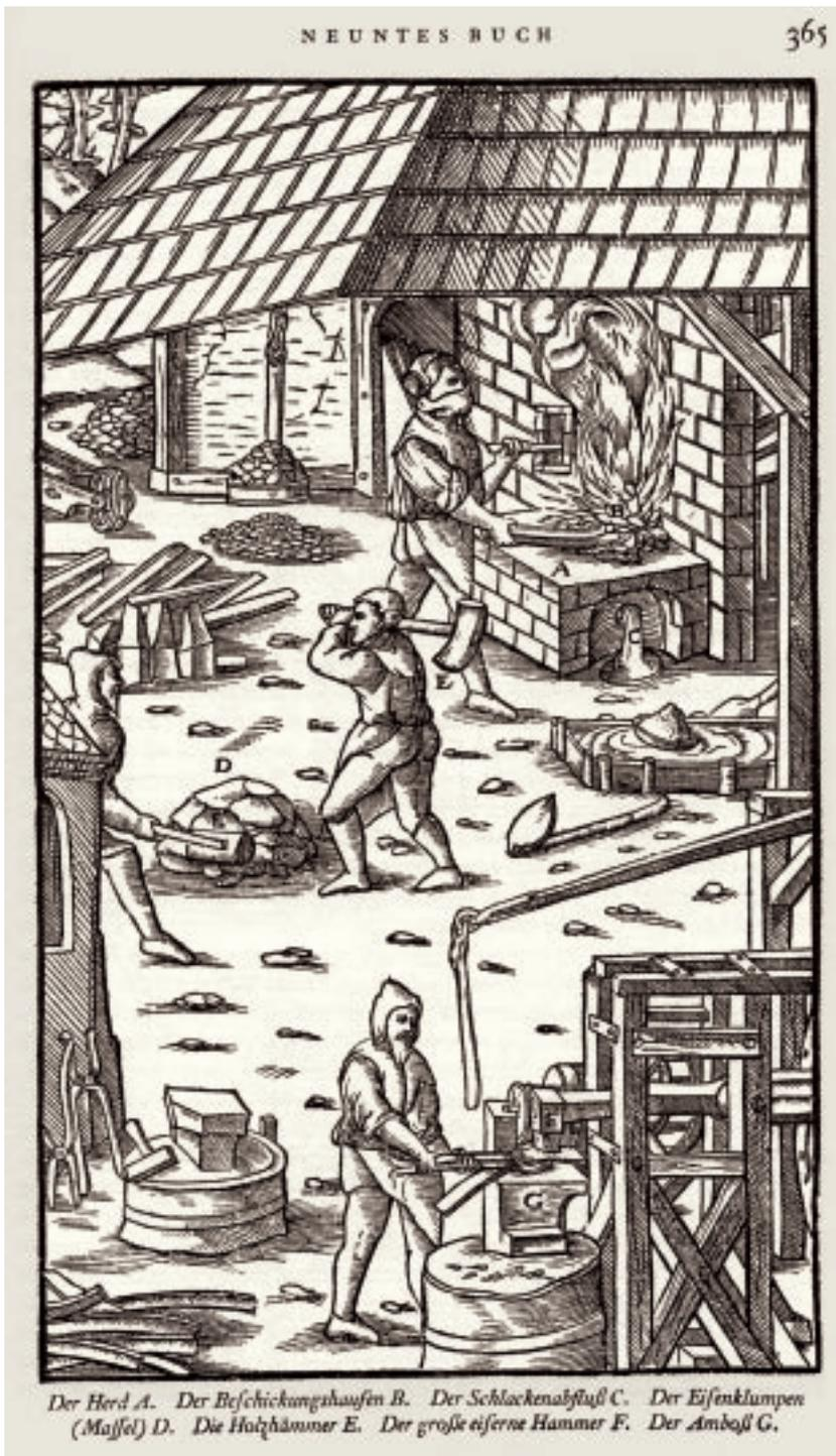
Der Herd A. Der Befchickungshaufen B. Der Schlackenabfluß C. Der Eifenklumpen (Maffel) D. Die Holzhlammer E. Der große eiferne Hammer F. Der Amboß G.
