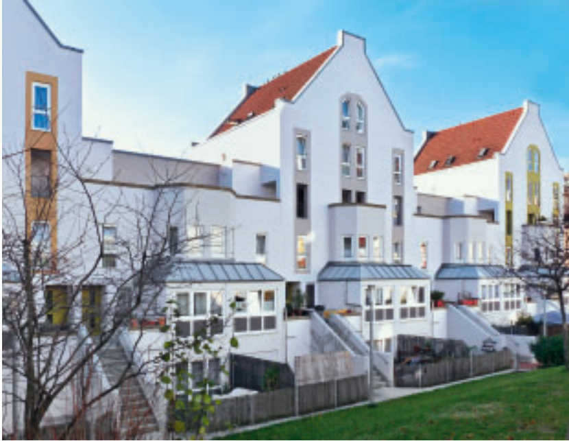
8 Stuttgart, Town Houses im Bohnenviertel.
