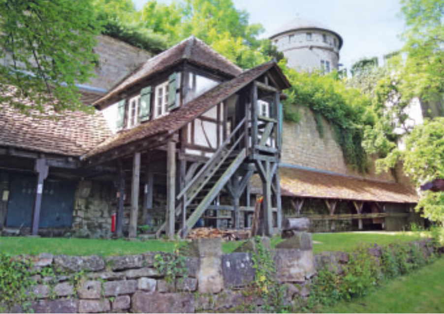
4 Die Kegelhahn mit zweigeschossigem Gartenhaus vor der Sanierung im Mai 2014.
