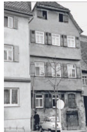
5 Das Haus Stumpengasse 1, erbaut 1435, vor seinem Abbruch im Februar 1977. Aufnahme um 1961.
