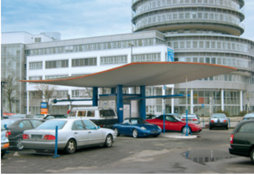
3 GASOLIN-Tankkiosk in Heidelberg von 1958.
