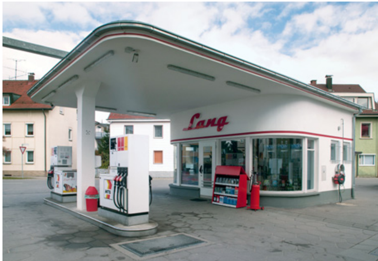
10 ESSO-Tankstelle Typ 50-1 in Tettang von 1950, nach Sanierung 2016.
