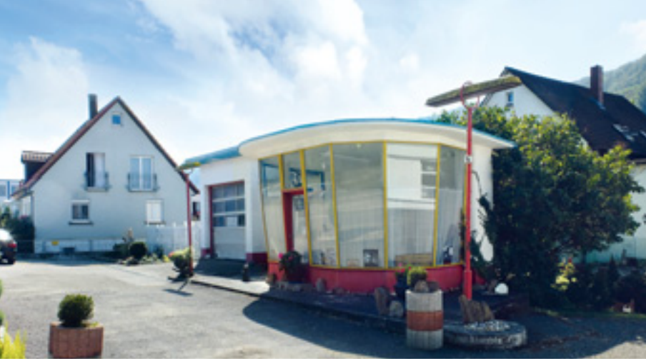
8 SHELL-Tankkiosk Type G in Ingelfingen; Kiosk von 1958, Pflegehalle von 1961.
