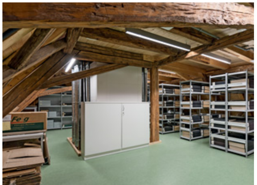
4 Dachgeschoss nach Westen, in der Bildmitte der Aufzogschacht.
