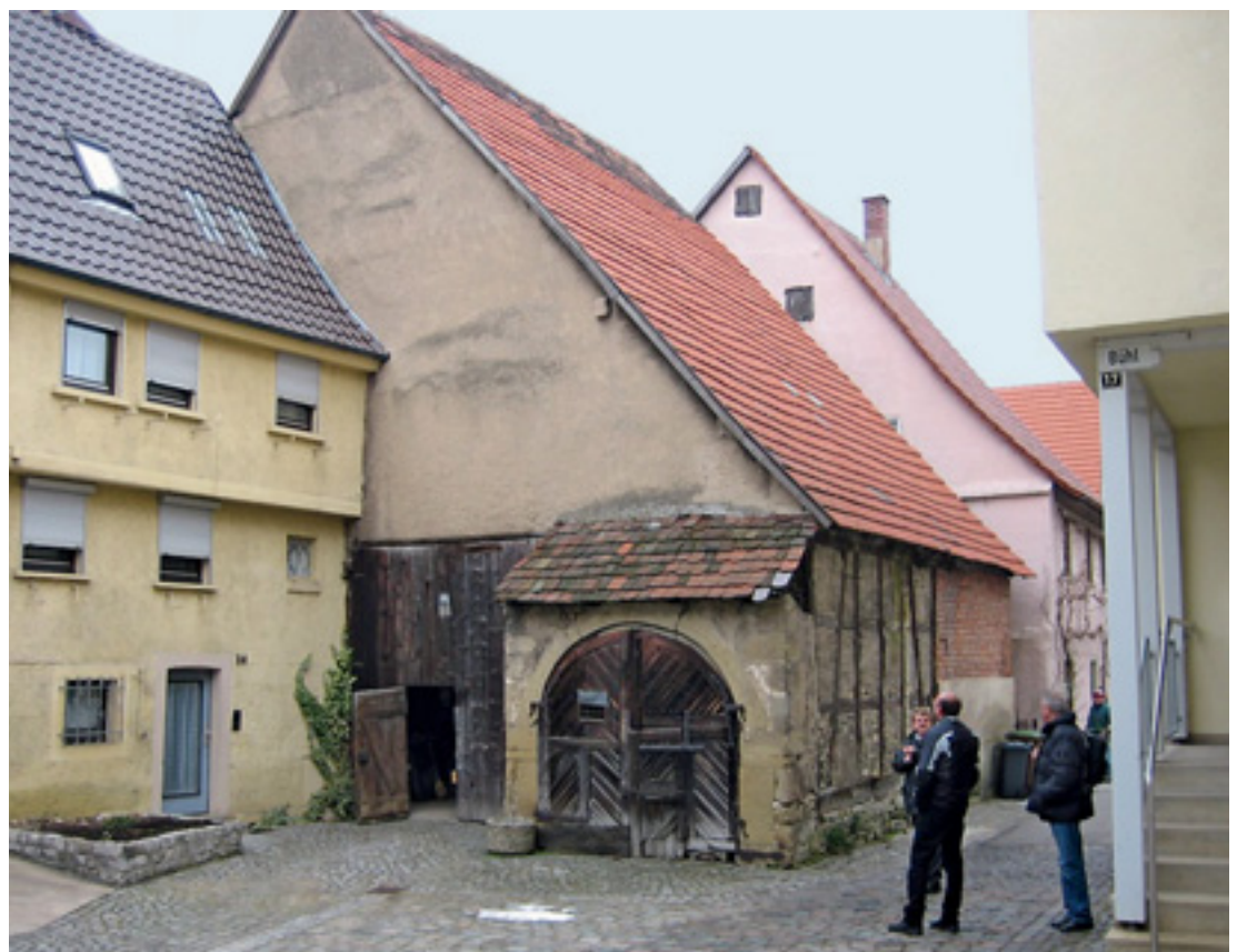
1 Die Scheune von Westen vor dem Umbau, 2010.
