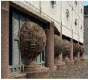
Kugelbäume aus Beton vor dem Bibliotheks- und Hörsaalgebäude der Universität Mannheim. Foto: Thomas Ott, Mühlthal.
