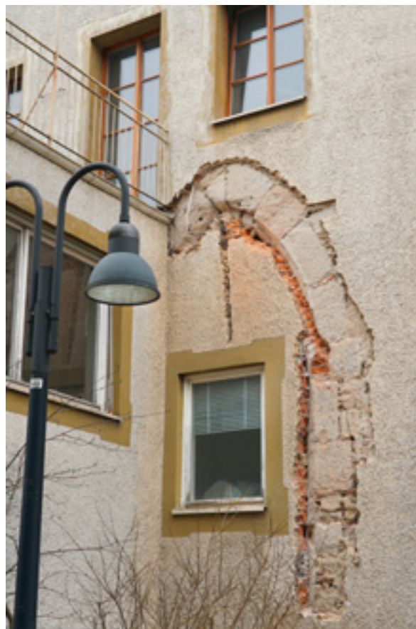
4 Westliches Eingangsportal des Erdgeschosses um 1288, sichtbar im westlich anstoßenden Nachbarhaus.
