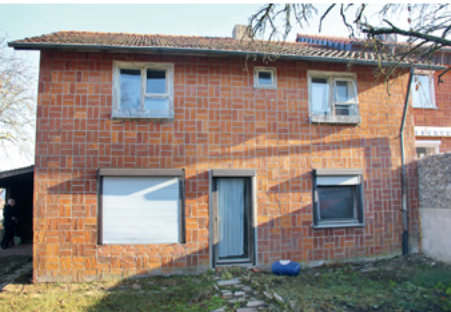
6 Ansicht nach der Instandsetzung (2018).
