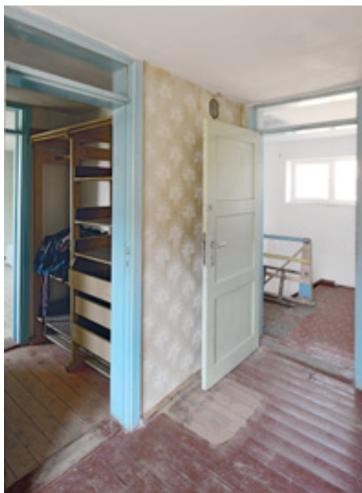
9 Blick ins Obergeschoss nach der Instandsetzung, 2018.
