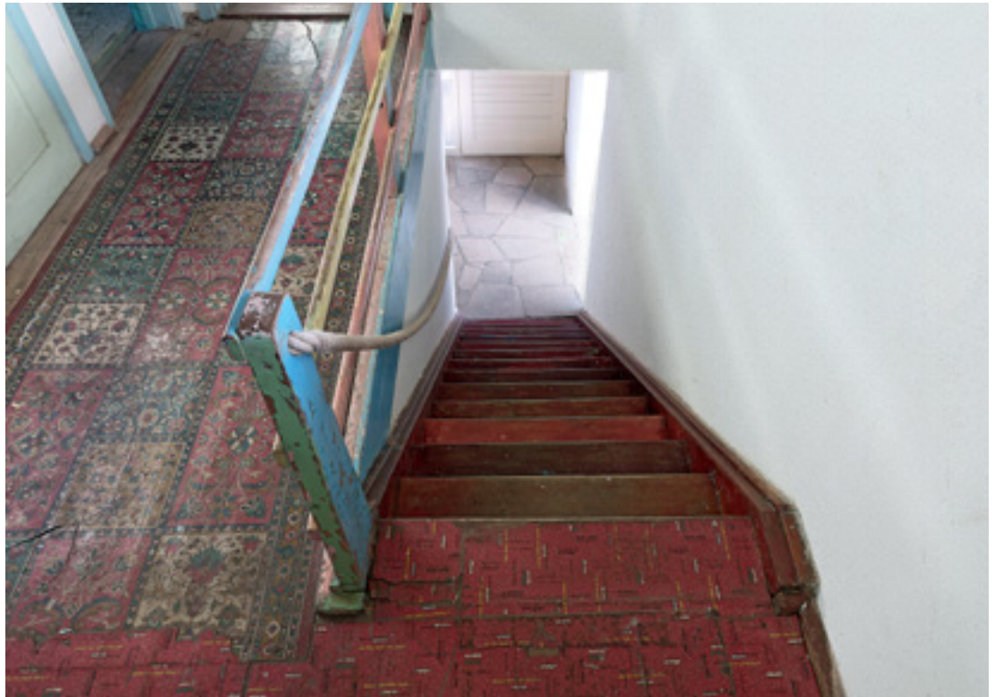
8 Treppe nach der Instandsetzung wieder mit Seil als Handlauf, 2018.
