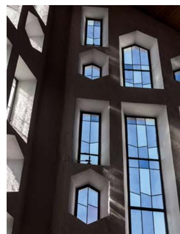
1 Detail der Fensterflächen an der südlichen Giebelwand der Versöhnungskirche in Ulm-Wiblingen. Ansicht von innen.
