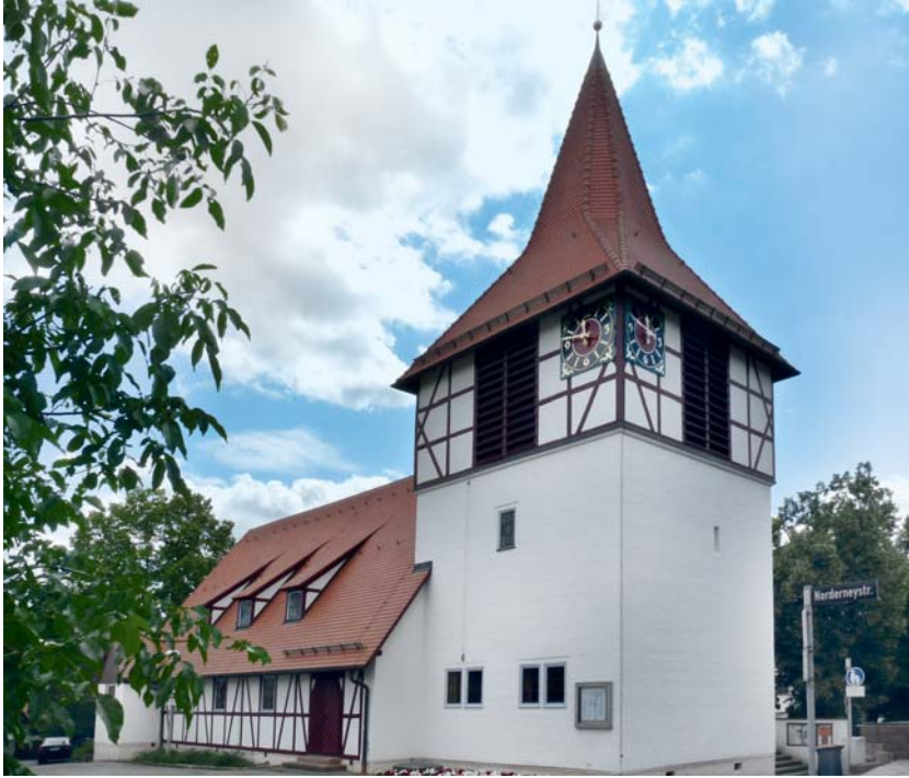
12 Stuttgart-Zuffenhausen, Neuwirtshaus, ev. Michaelskirche, 1938 als erster Kirchenneubau samt Pfarrhaus und Gemeindegewerbestenhaus nach Entwurf des Architekten Paul Heim.
