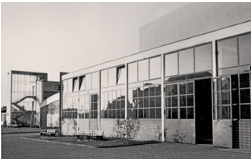
2–3 Kesselhaus mit Werkstattgebäude zwischen 1956 und 1960. Blick nach Nordosten (oben), Blick von Nordwesten (unten).
