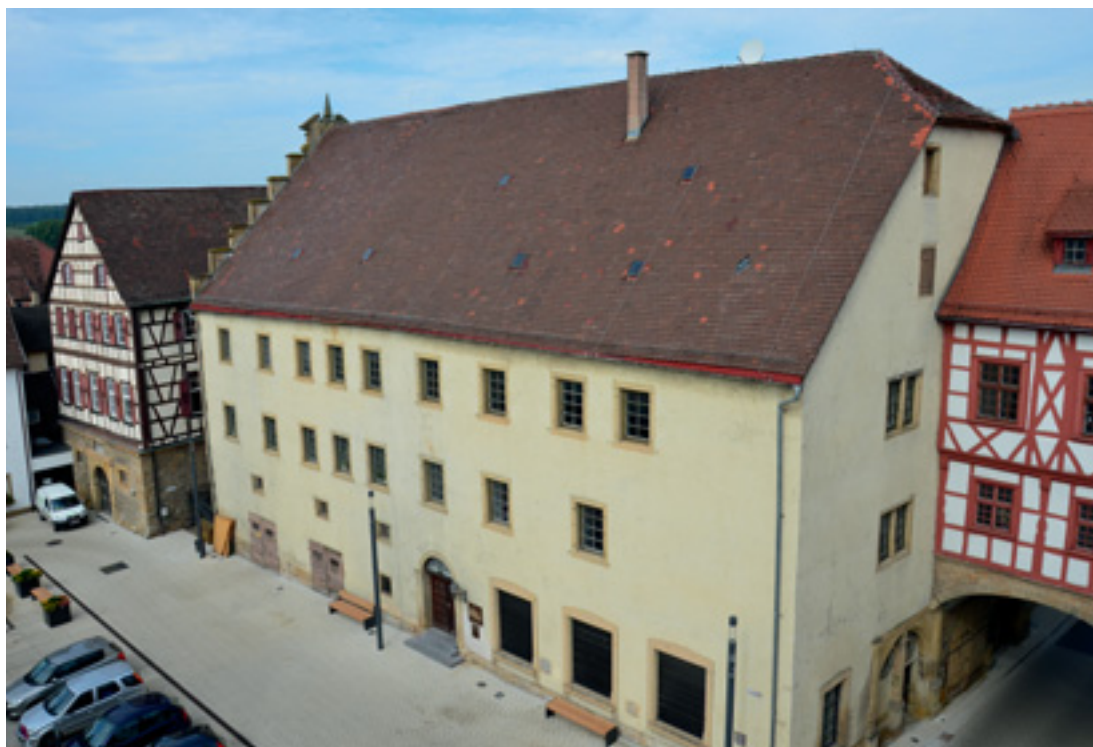
1 Marktplatzansicht des Türnitzbaus 2013. Die schmucklosen Fenstergewände der beiden Obergeschosse entstanden nach 1840, jene im Erdgeschoss, rechts des Hauseinganges, um 1865 mit dem Einbau einer Poststation. Die beiden Garagentore wurden 1926 eingebrochen, anstelle bauzeitlicher Renaissancegewände. Die kleinen Gewände über den Toren belichten ein Zwischengeschoss über gewölbten Kammern. Der ursprüngliche Nebeneingang wurde 1844 mit dem Einbau des heute erhaltenen Elementes zur Hauseingangstür.
