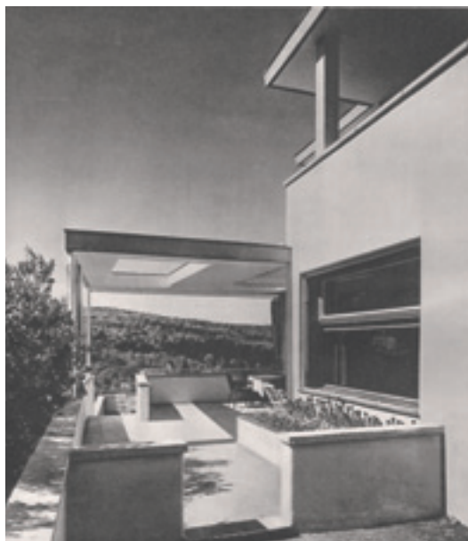
13–14 Haus Dr. Kilpper von Westen (links) und Terrasse an der Ostseite mit Vordächern (rechts), 1928.
