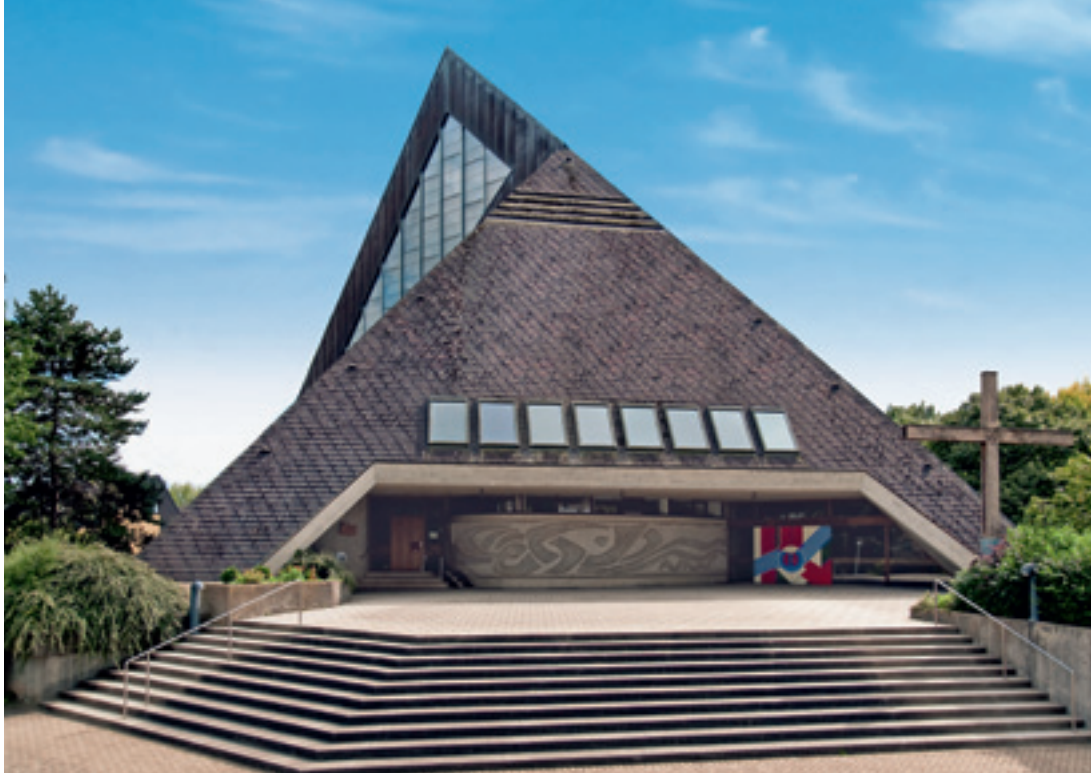
8 Außenansicht der katholischen Kirche St. Johannes in Emmendingen.
