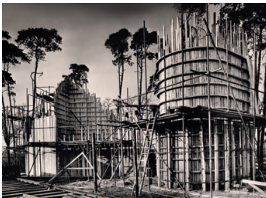
2 Betonierarbeiten der Blumenau-Kirche 1960: Aus einem Guss.
