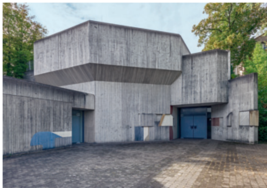
11 Stuttgart-Heslach, St. Josef. Ein „Flak-Bunker“ im Gründerzeitviertel.
