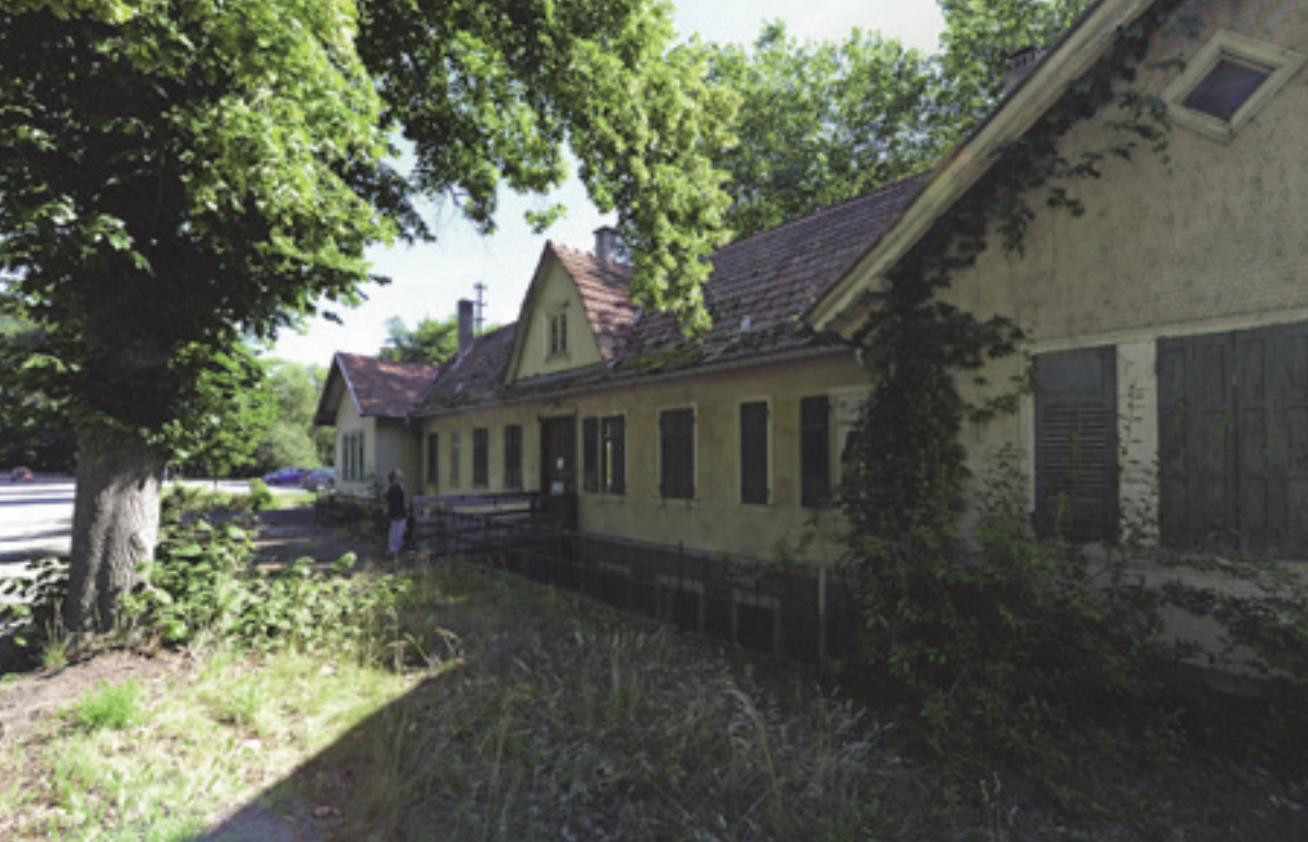
3 Zustand der Straßenansicht vor dem Beginn der Sanierungen.
