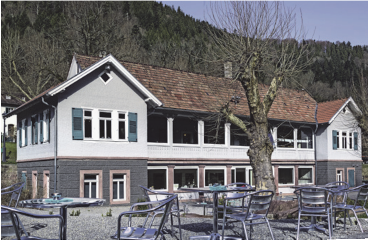
9 Nach der Sanierung, die beiden Galerien wurden wieder geöffnet.
