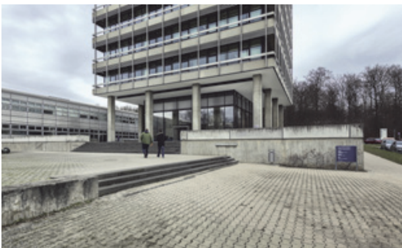
4 Hochhaus der MPA.
