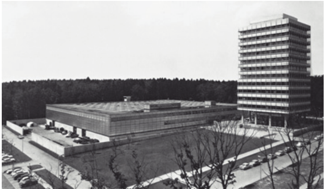
2 Gesamtkomplex der MPA nach Fertigstellung.
